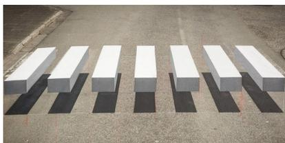
Certaines communes mettent en place des **passages pour piétons en 3D**. Il s'agit d'un marquage au sol avec un effet visuel en trois dimensions (trompe l'œil) qui simule la présence d'un obstacle afin d'inciter l'automobiliste à ralentir.
